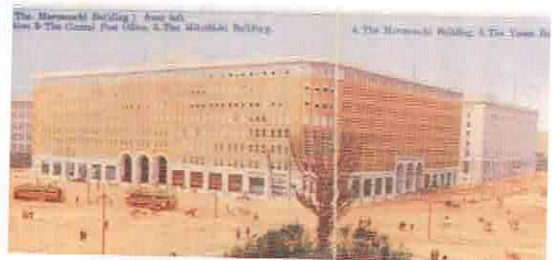
図 2 丸の内ビルディング（高さ 31m、1923 年）
